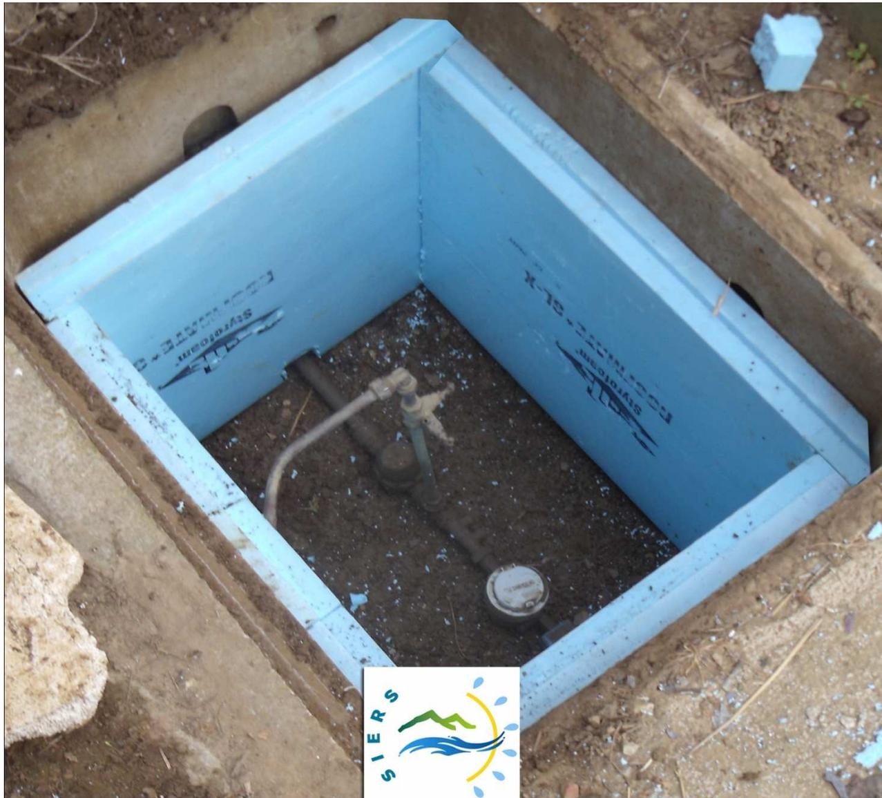
**2 - Faire des ajustements dans la découpe des plaques de polystyrène en tenant compte des équipements intérieurs (tuyaux, robinets...) et placer les plaques contre les parois.**
