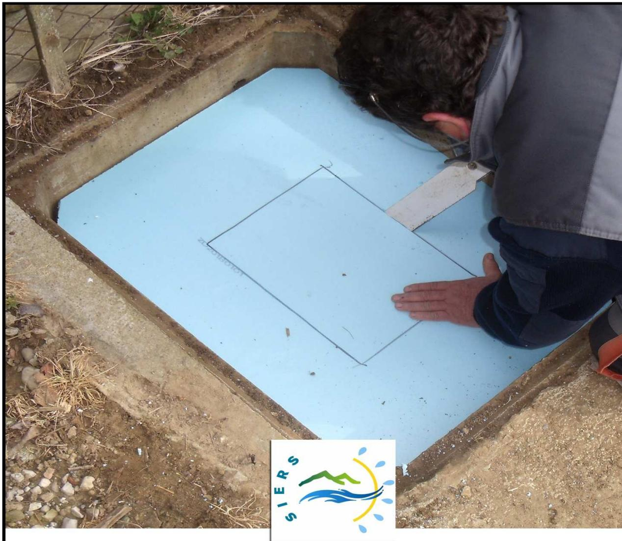
**3 - Découper une plaque de polystyrène en tenant compte des dimensions de la section intérieure du regard et la placer en partie supérieure du regard (couverture). Tracer ensuite les contours d'une trappe d'accès au compteur.**
